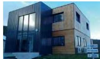
La construction modulaire est un procédé de fabrication et d'assemblage de modules en atelier, en fonction d'un projet personnalisé (maison, bureau, école, local médical...). Le concept novateur allie à la fois le métal, le bois et le béton. C'est la combinaison gagnante qui permet d'être performant. Les finitions intérieures et extérieures sont adaptées à vos contraintes et envies. Soucieux du confort thermique, cette société de construction emploie des isolants écologiques tels que
